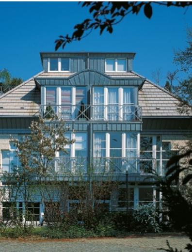
Als zweischalige Ausführung mit der Möglichkeit sehr großer Dämmstoffdicken ist die hinterlüftete Außenwandbekleidung bauphysikalisch unübertroffen.
